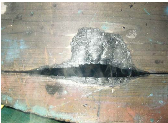
【 焼っていた足場板 】
